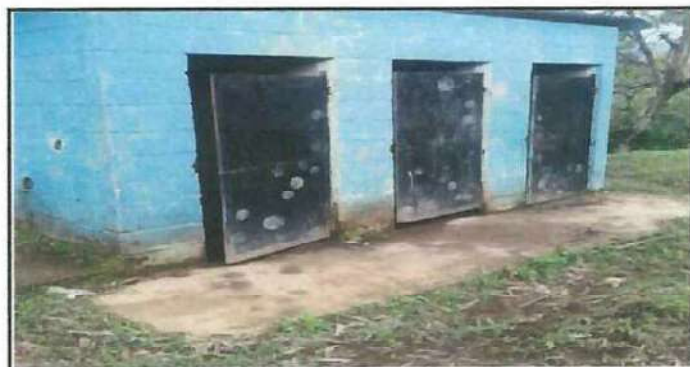
Foto 6: Puertas del servicio sanitario en mal estado, necesita su mantenimiento.
