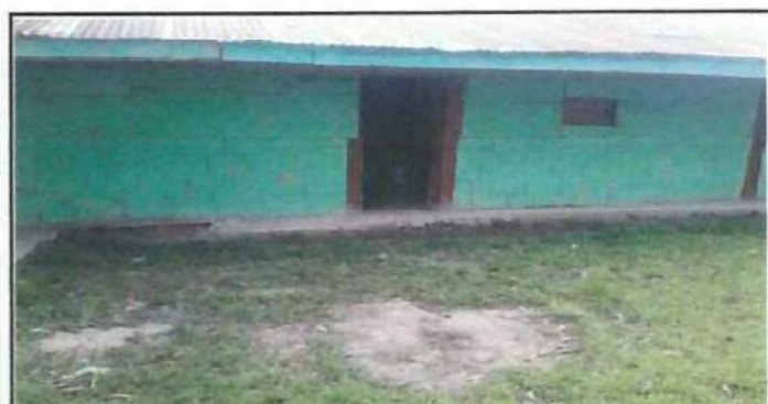
Foto 5: Vista del aula que carece de ventanas, necesita mejorar y sustituir las ventanas de madera por ventanas de metal.
