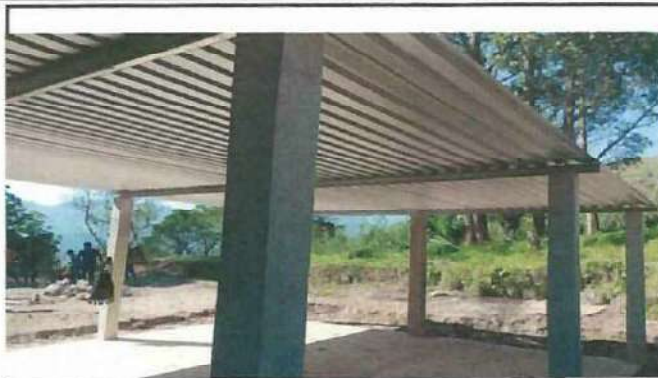
Foto 2: Vista frontal las columnas
